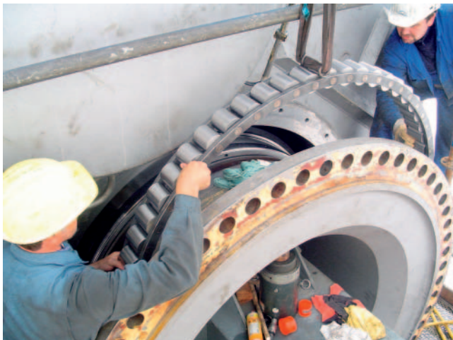
FAG- und Tenova TAKRAF-Monteur montieren eines der Käfigsegmente
