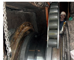
Travaux de montage d'un roulement à rotule sur rouleaux FAG sur le convertisseur
