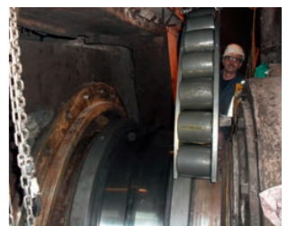
Montagearbeiten eines FAG-Pendelrollenlagers am Konverter
