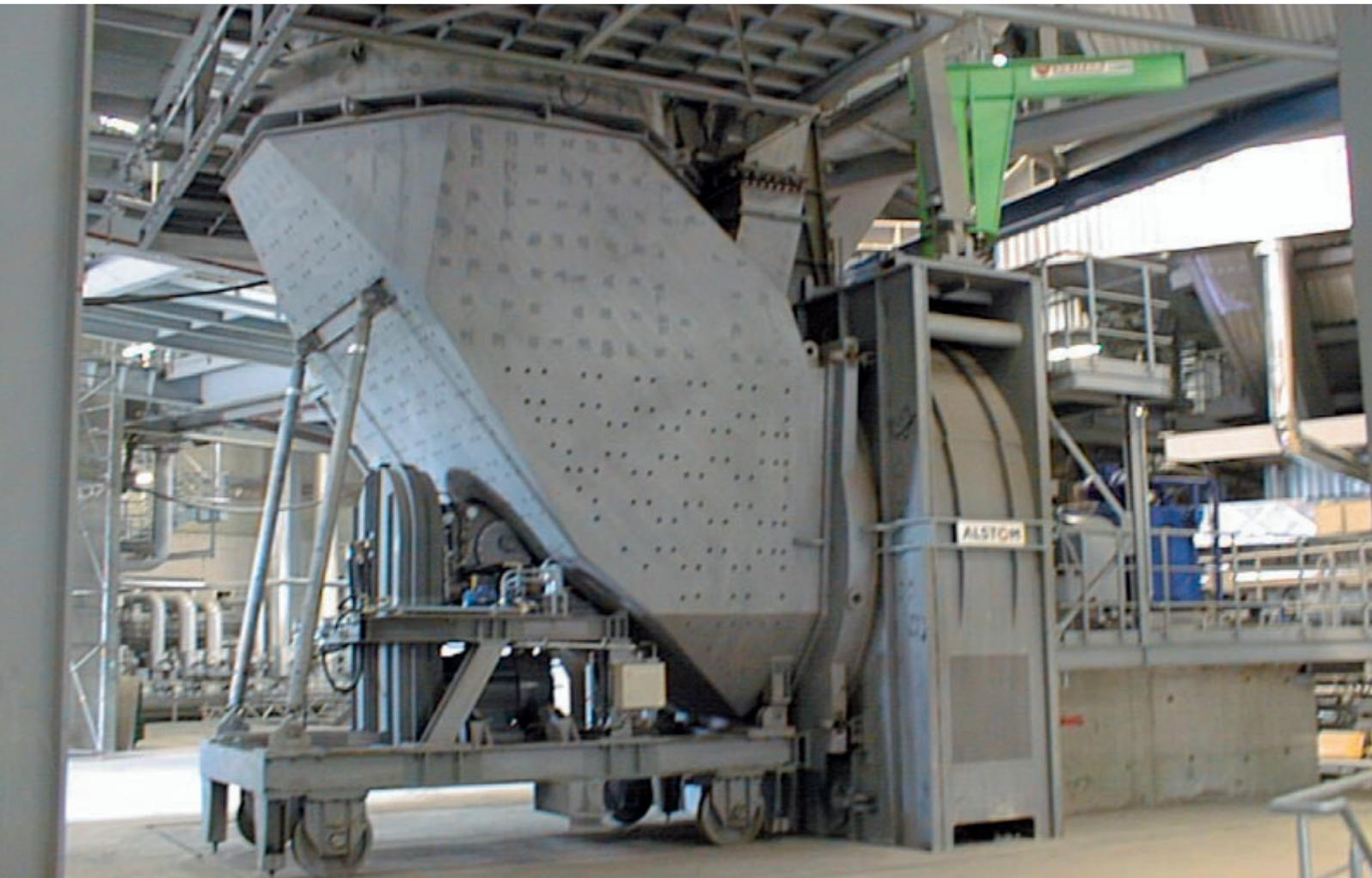
Schlagradmühle N 535.43V von ALSTOM Power Stuttgart, Deutschland
