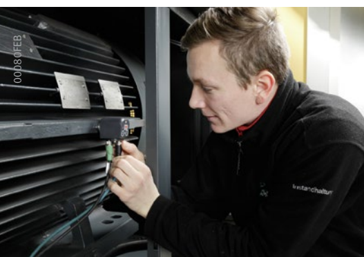
Installation eines Online-Systems
