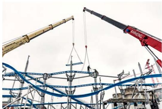
Insgesamt zehn Lastwagen bringen die Achterbahn-Teile zum Aufbauplatz. Ein gigantisches Puzzlespiel aus Kurven, Wagen und Ständerwerk. Große Ausliegerkranwagen heben die teilweise tonnenschweren Bauteile in Position. Drei Tage dauert der Aufbau
