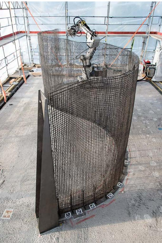
Ein industrieller Roboter (In situ Fabricator) erstellt eine 3D-Gitterstruktur, die mit einem Beton ausgefüllt wird, der über spezielle Fließigenschaften verfügt
