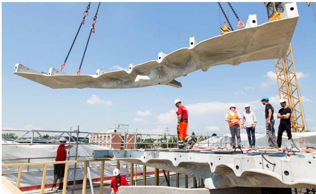
Digital geplant, additiv gefertigt: Die geschwungenen Deckenelemente, die in einer im 3D-Druck gefertigten Schalung gegossen wurden, werden auf der Baustelle zusammengefügt
