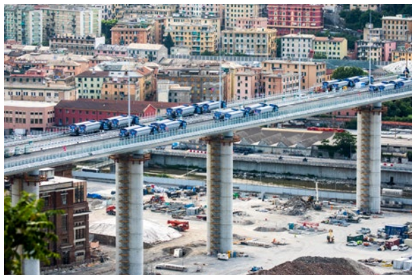
Bei einem mehrtägigen Belastungstest querten bis zu 50 Lkw mit insgesamt 2.500 Tonnen Gewicht gleichzeitig die Brücke
