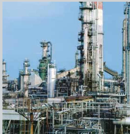
Použití v oblasti petrochemického průmyslu: čerpadla v rafinériích
