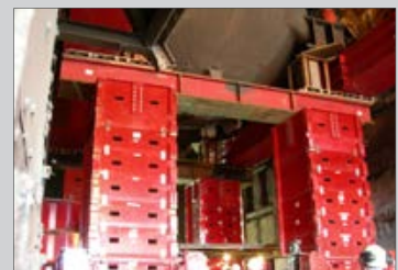
Estructura de soporte del recipiente
