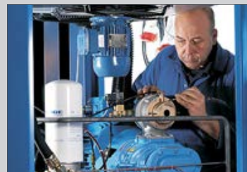
Mantenimiento de un compresor de hélice de Boge
