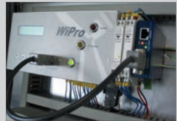
Sistema de monitorización online FAG WiPro
