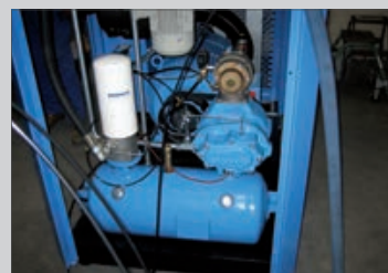
Monitorización de un compresor de hélice de la empresa Boge
