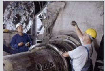
Montadores trabajando in situ
