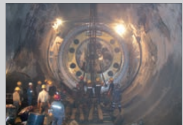
Tuneladora (TBM) en funcionamiento
