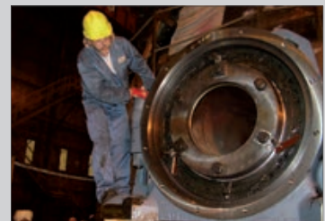
Trabajos de montaje en el soporte
