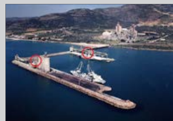
Cinta transportadora en el puerto
