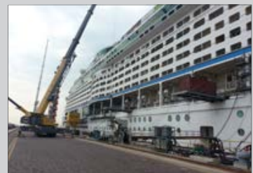
Renovación general en el dique seco
