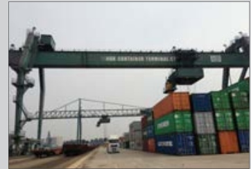
Grúa pórtico en el puerto de mercancías
