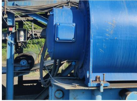
Schaeffler CONCEPT2 im Schutzkasten am Antriebsmotor
