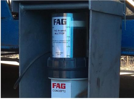
Schaeffler CONCEPT2 im Schutzkasten am Antriebsmotor
