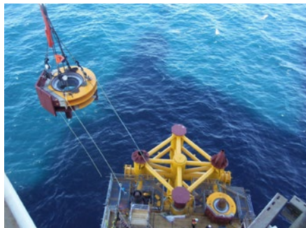
La segunda unidad se colocó con la ayuda de una grúa
