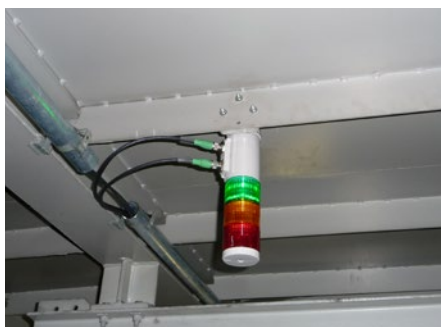
Visualización sencilla del estado en funcionamiento con la ayuda de FAG SmartLamp
