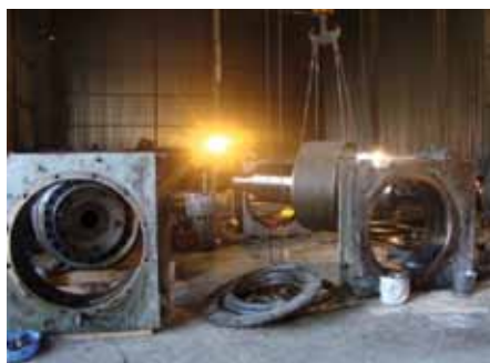
Очистка и осмотр опорных элементов и валов
