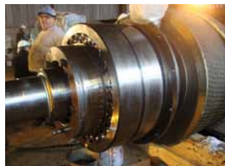
Монтаж новых подшипников
