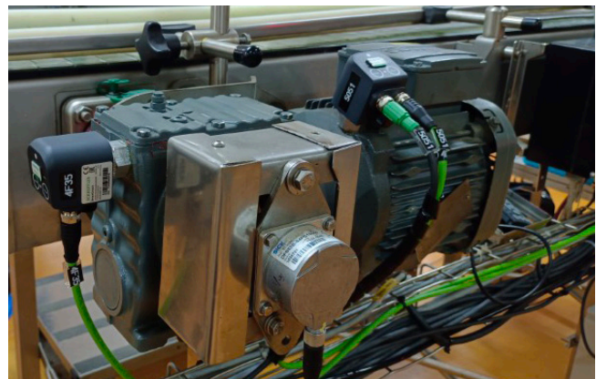
SmartCheck am Servomotor installiert
