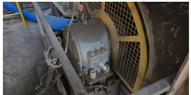
OPTIME-Sensoren an einer nicht angetriebenen Seite des Lüfters
