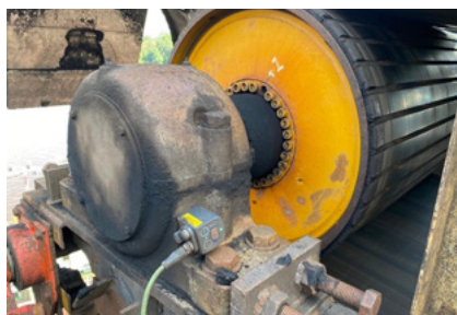
SmartCheck installé sur le corps de palier
