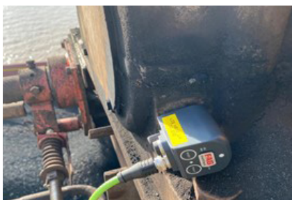
SmartCheck installé sur le corps de palier
