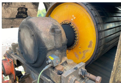
SmartCheck am Lagergehäuse installiert
