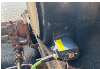
SmartCheck am Lagergehäuse installiert
