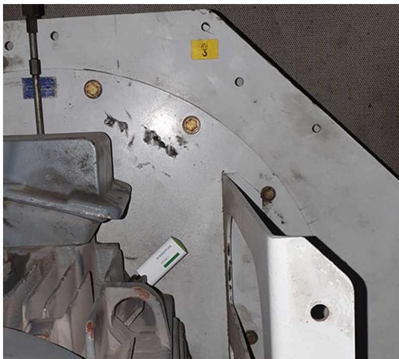
Le capteur OPTIME situé sur le moteur d'un ventilateur de refroidissement a rapidement détecté l'état modifié de la machine.
