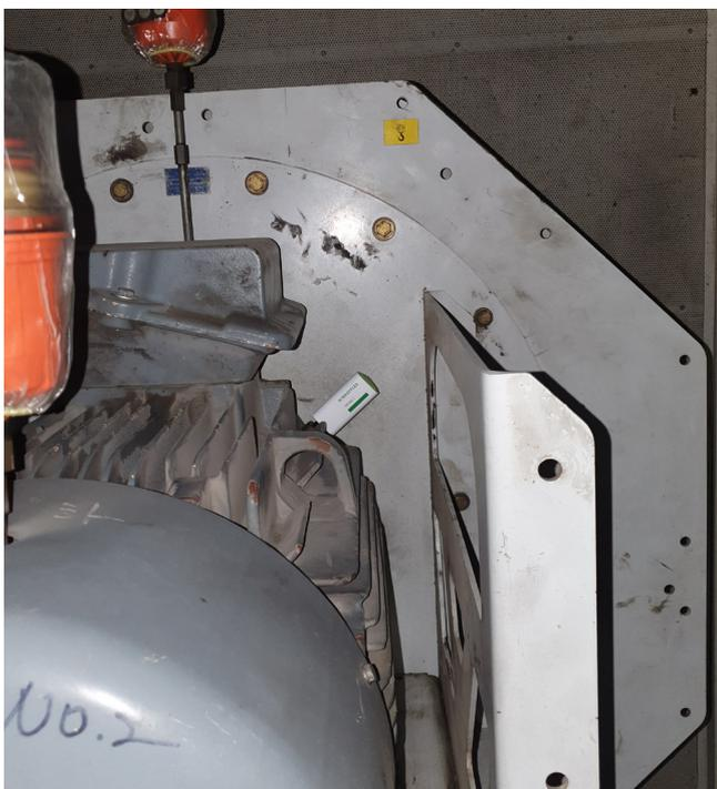
Der OPTIME Sensor am Motor eines Kühlventilators detektierte frühzeitig den veränderten Maschinenstatus.
