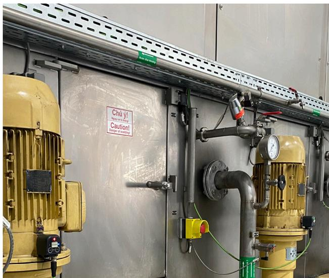
SmartChecks installés sur les pompes critiques.
