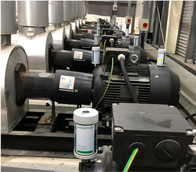
Le CONCEPT1 est installé sur les moteurs et les pompes.
