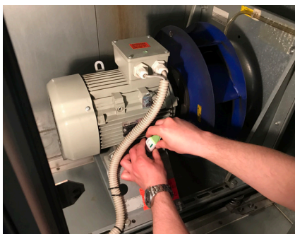
Der OPTIME-Sensor wird montiert.
