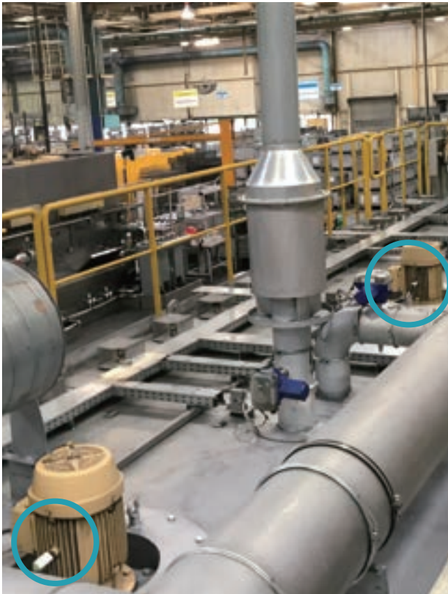
모터에 설치된 OPTIME 센서
