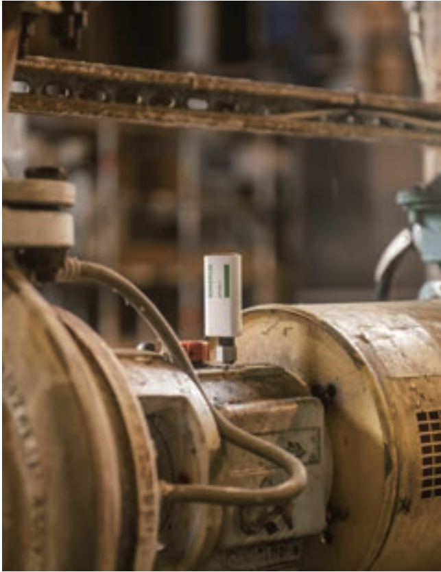
펌프에 설치된 OPTIME 센서
