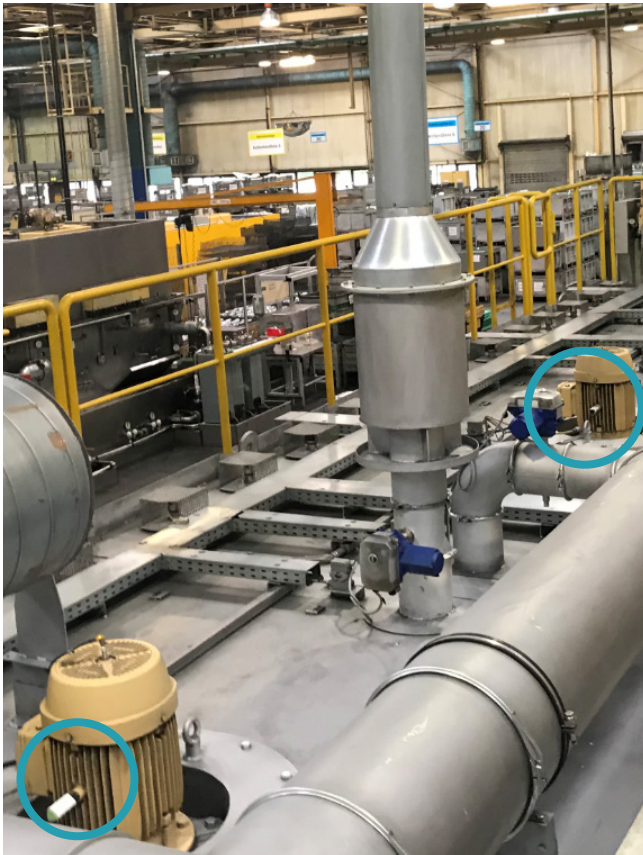
OPTIME-Sensoren an Motoren
