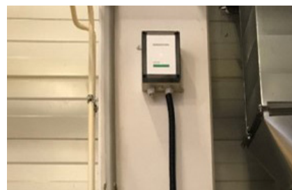
Passerelle installée sur le mur
