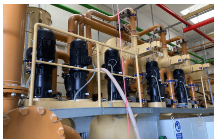
Système OPTIME sur les pompes du système d'alimentation en huile
