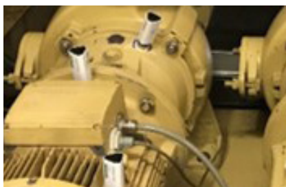
Vue rapprochée : Capteurs OPTIME sur un moteur KSB
