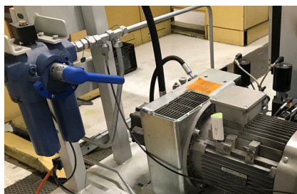
Système OPTIME sur un moteur du système hydraulique
