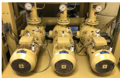
Capteurs OPTIME sur les moteurs KSB
