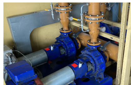
Système OPTIME sur les pompes du système principal d'alimentation en huile
