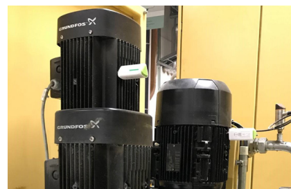
Système OPTIME sur les moteurs d'une pompe pour émulsion
