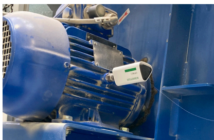
Système OPTIME sur un moteur de refroidissement
