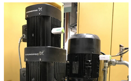
OPTIME an Motoren einer Emulsionspumpe
