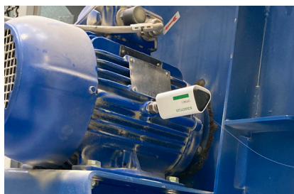
OPTIME an einem Kühlmotor
