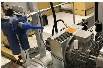
OPTIME an einem Motor der Hydraulikanlage
