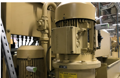
OPTIME an Motoren einer Emulsionspumpe
