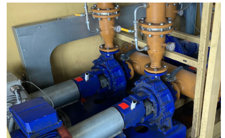
OPTIME an den Pumpen des Hauptölversorgungssystems
