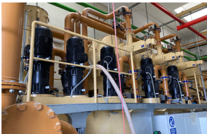
OPTIME an Pumpen der Ölversorgungsanlage
