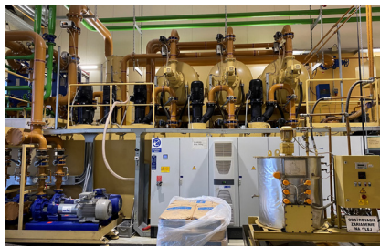
Zentrale Ölversorgungsanlage
