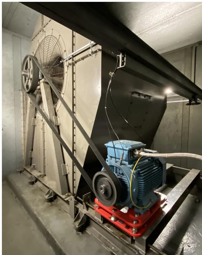
Ventilateur avec plateau motorisé en 3D breveté et entraînement par courroie crantée dans l'usine du constructeur automobile
