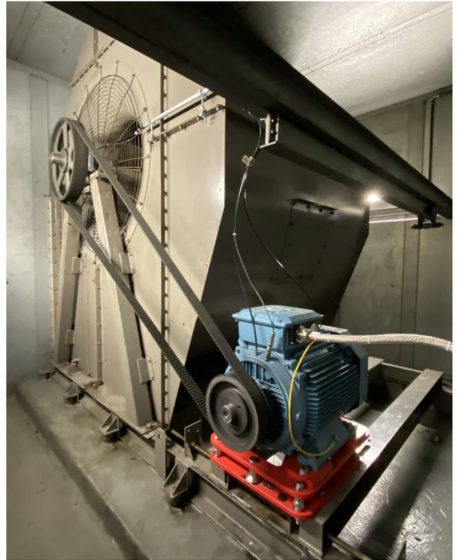
Ventilador con unidad de montaje ajustable en 3D patentada y accionamiento con correa dentada en la planta del fabricante de automóviles
