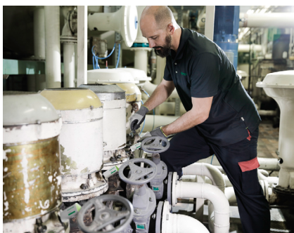
Schaeffler OPTIME se instala en la sala de suministros.
