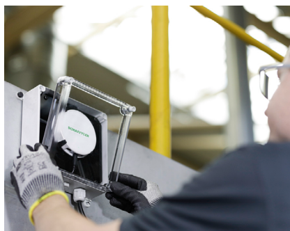
La puerta de conexión se monta en el muro.
