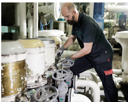
Im Versorgungsraum wird Schaeffler OPTIME montiert.
