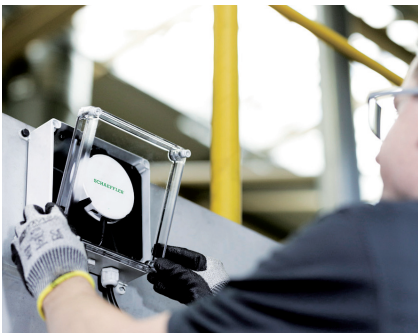
网关安装在墙上。
