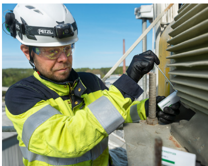
Montage de Schaeffler OPTIME.
