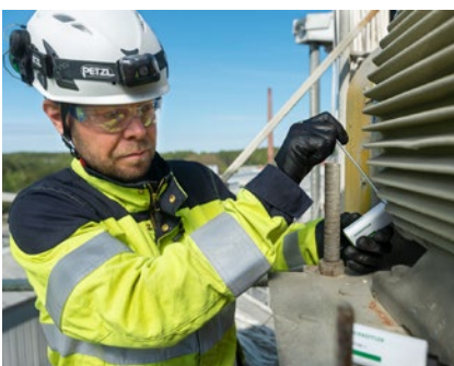
Montaje de Schaeffler OPTIME
