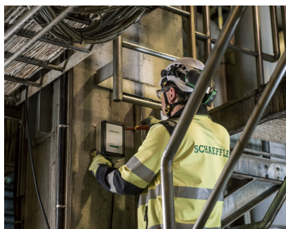
Installation de la passerelle.
