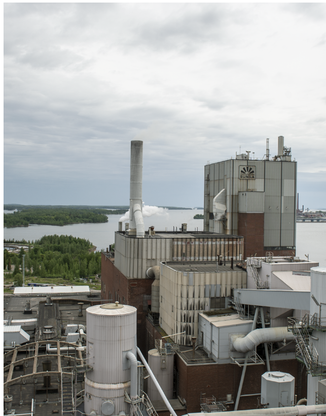
Planta de Sunila, Kotka, Finlandia
