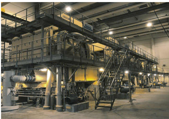
Interior de la planta de Sunila
