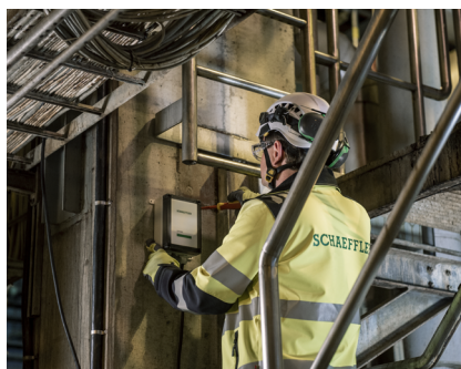
Se monta la puerta de conexión.
