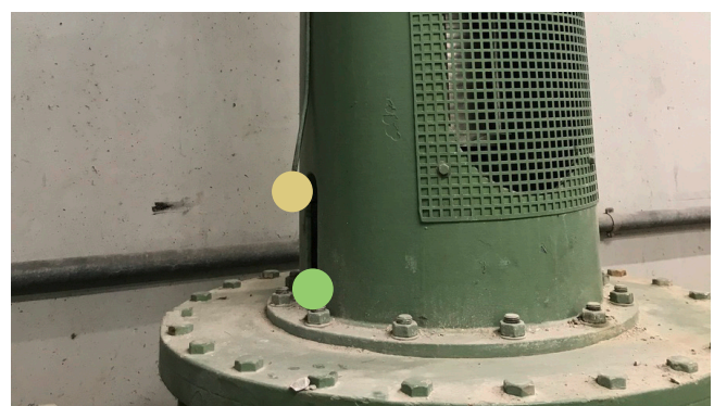
SmartCheck et CONCEPT2 pour la surveillance et la lubrification de la pompe
