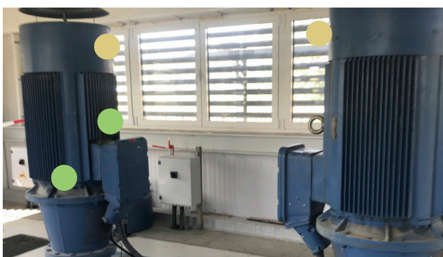
Surveillance du moteur avec SmartCheck et système de lubrification CONCEPT2
