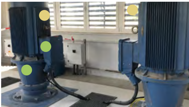
Monitorización de los motores mediante SmartCheck y el sistema de lubricación CONCEPT2
