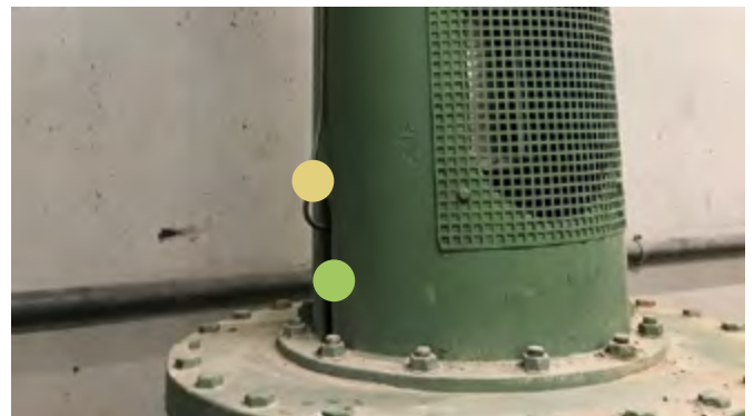
SmartCheck y CONCEPT2 para la monitorización de las bombas y la lubricación
