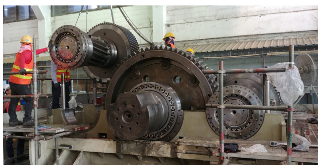
Montage de la transmission
