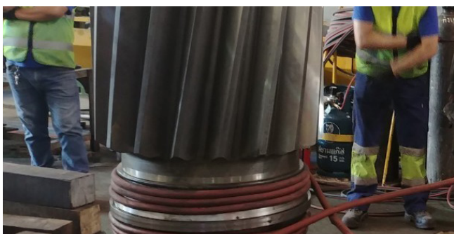
Démontage en chauffant la bague intérieure sur l'arbre
