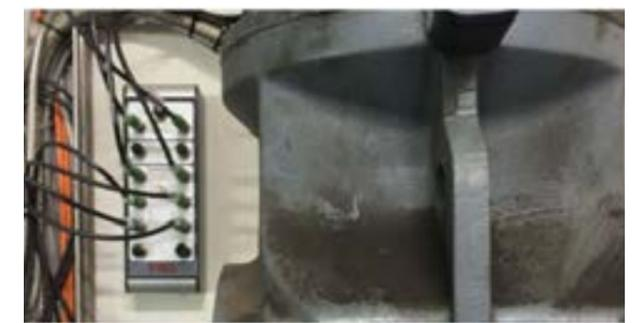
La unidad SmartConnect Box distribuye el voltaje y las señales adicionales hacia hasta cuatro dispositivos SmartCheck (aquí todavía en el diseño antiguo de FAG)
