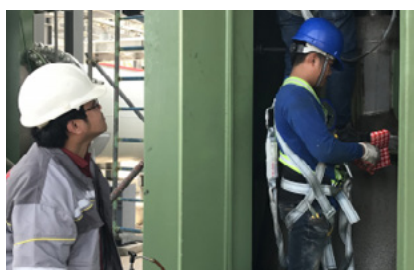
Collaborateurs installant les capteurs SmartCheck.
