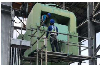
Collaborateurs discutant de l'installation des capteurs.
