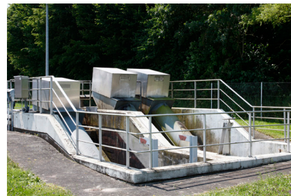
Rücklaufschlammumpwerk
