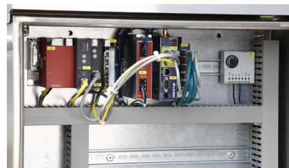
Schaltschrank: MELSEC System Q und eWon Router
