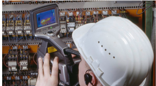
Schaltanlage wird mit einer Wärmebildkamera untersucht
