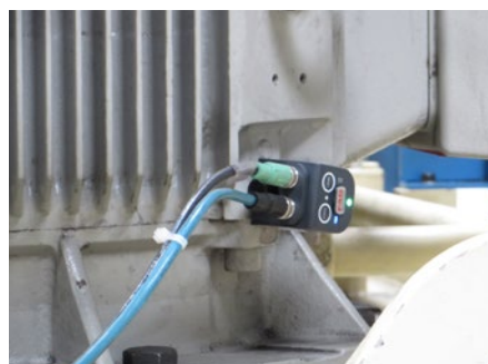
FAG SmartCheck am Fuß eines Antriebmotors
