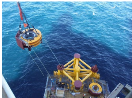
Per Kran wird die zweite Einheit herabgelassen
