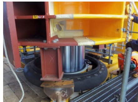
Bei der Montage mussten die Monteure Millimeterarbeit durchführen
