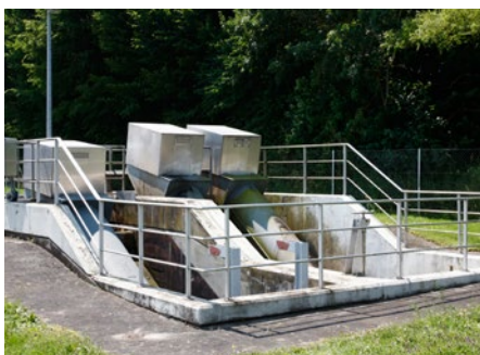
Rücklaufschlammumpwerk
