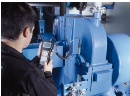
Messung zur Zustandsüberwachung
