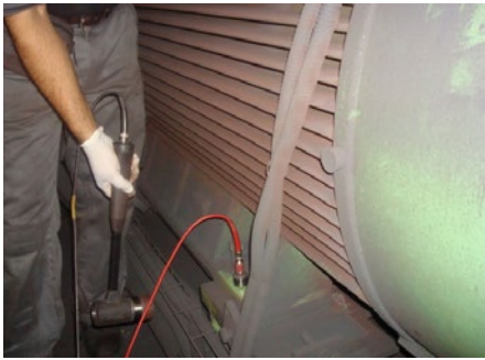
Sensorpositionen am Motor-Fundament für den sogenannte „Bump Test“
