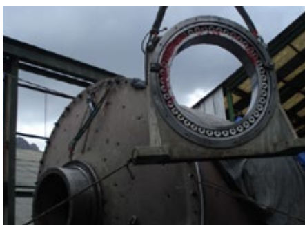
Die Montage von Großlagern erfordert Fachwissen und fachgerechtes Werkzeug
