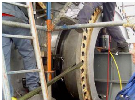
Für den Ausbau der Innenringsegmente des alten Lagers wurden Spezialwerkzeuge angefertigt
