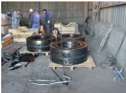
Demontage der Lager
