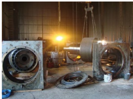
Reinigung und Inspektion der Abstützteile und Wellen
