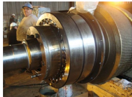
Montage der neuen Lager
